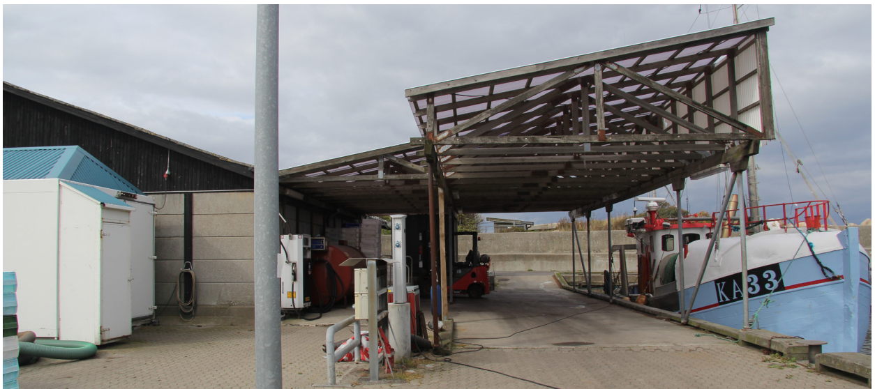
■ Eksisterende forhold Overdækning ved fiskesalg fra dæk
