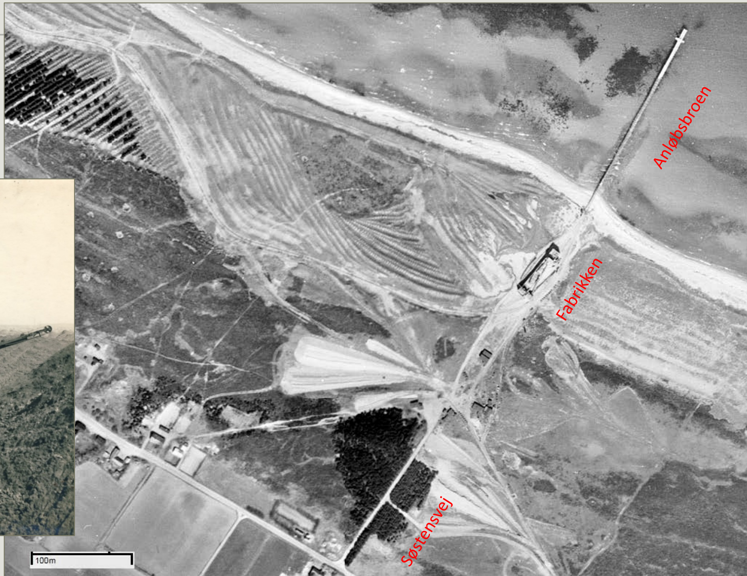
Topper efter gravning i området
